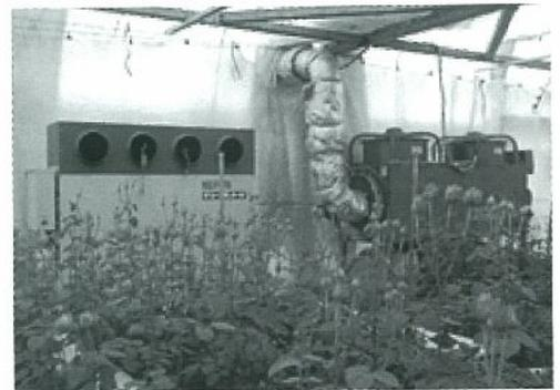
バラ栽培のためのヒートポンプによる加温・冷却・除湿用装置
