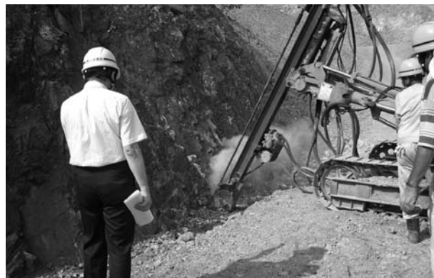
削岩孔植植工法：削岩機で穴を開け、保水性土壌苗キットを差し込み作業は完了。
