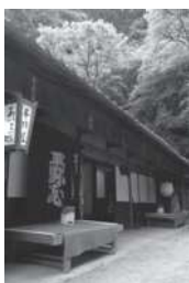
古民家耐震改修
