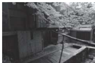
古民家耐震改修
