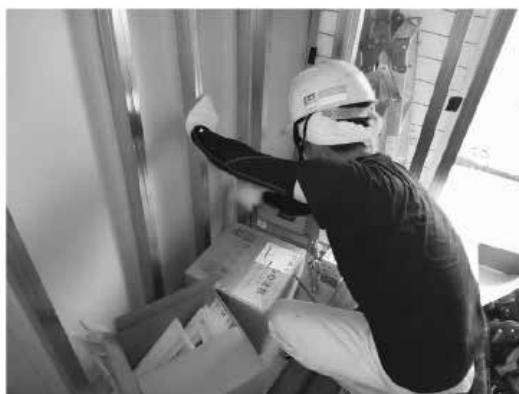
LPガス設備設置施工現場
