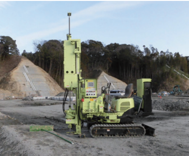
新造試験機による盛土管理
