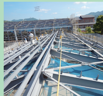
体育館新築屋根工事
