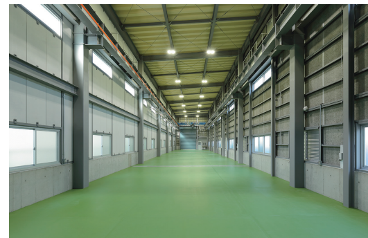
令和2年新設工場内部
