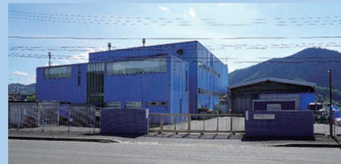
第一工場全景
