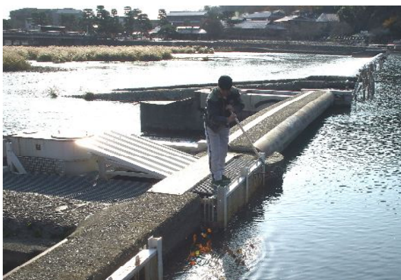
取水口をふさぐと発電量が下がるため、毎日、川から流れてくる落ち葉やゴミを取り除く作業を行う。
