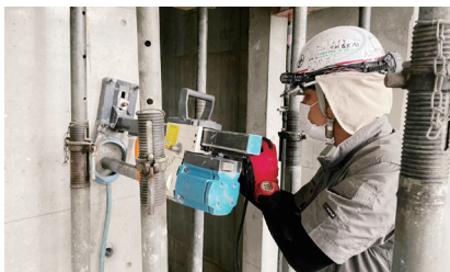
あと施工アンカー工事の現場 緊急性の高い工事へのスピーディーな対応が強み
