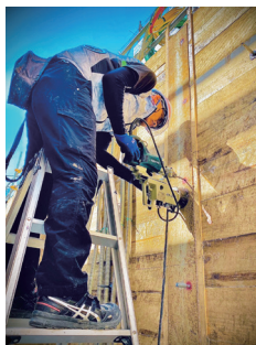
あと施工アンカー工事の現場 緊急性の高い工事へのスピーディーな対応が強み
