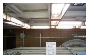
照明 LED 工事
