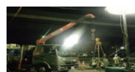
配水管布設工事
