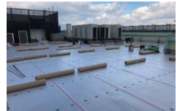
屋上防水改修
