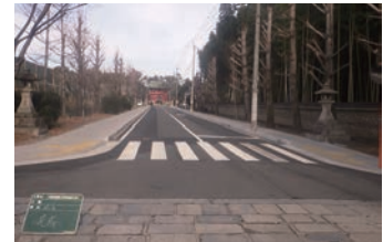
舗装道補修工事
