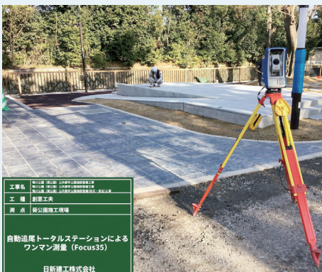
一人での測量作業と電子黒板の使用例
