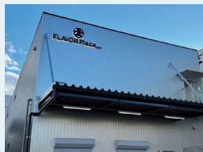
昨年12月竣工の工場
