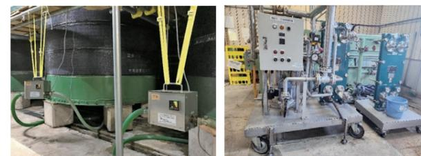
電磁弁サーモセット プレートヒータ簡易ユニット
